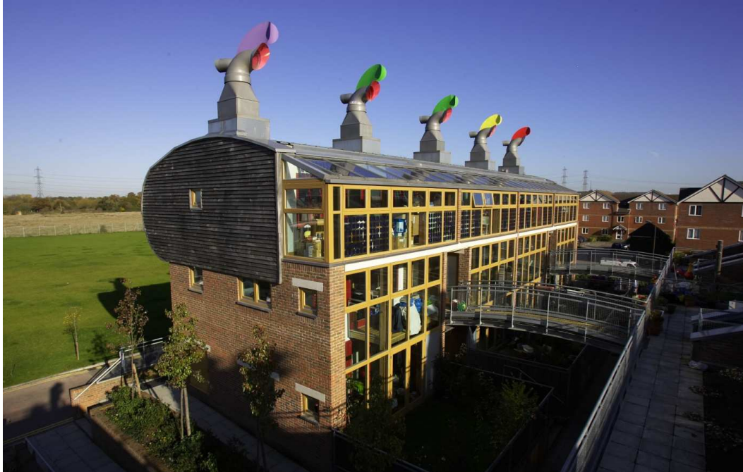
Fot.24 Osiedle Bedzed
