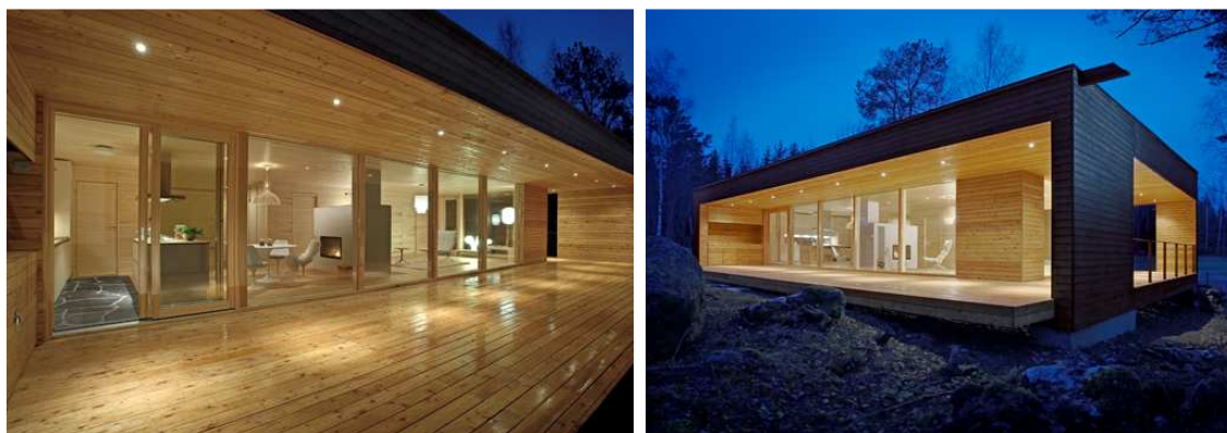
Fot. 52,53 Dom Honkatalot 'Huvilat 80' wykonany techniką facherkową
