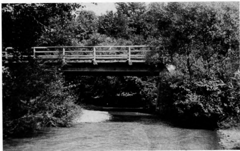
Most remontowany po działaniach wojennych
