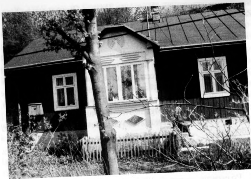
Typowy dom z gankiem - jakie budowano po II wojnie światowej
