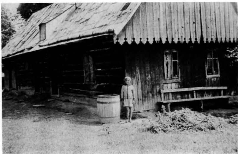
Obora i dom pod jednym dachem
