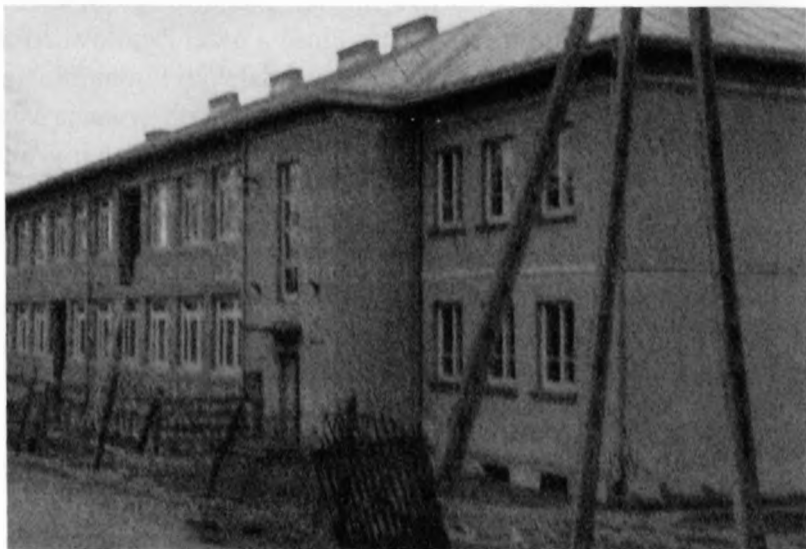
Szkoła w budowie
