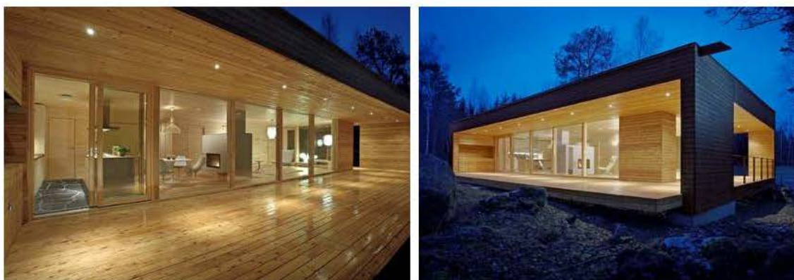
Fot. 52,53 Dom Honkalot 'Huvilat 80' wykonany techniką fachwerkową
